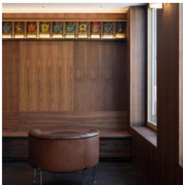
Die Nussbaumverkleidung gibt dem Wappenzimmer ein sehr edles Kleid. Die indirekte Beleuchtung setzt den Fokus auf die Familienwappen und leuchtet den Raum über die weisse Decke dezent aus.
